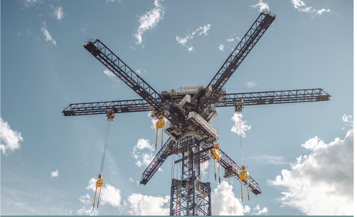
Kaynak: Energy Vault
