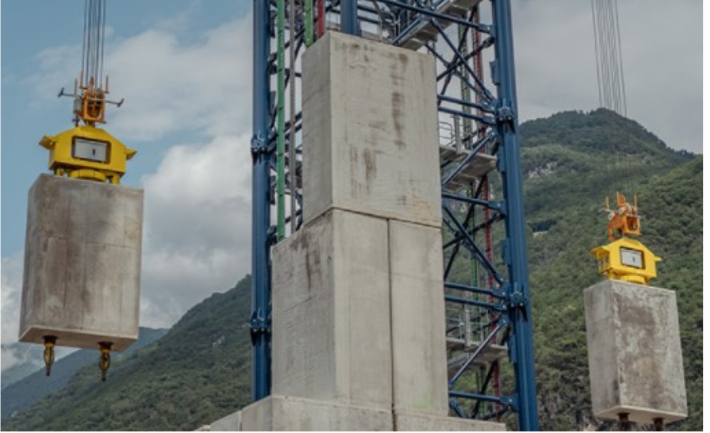
Kaynak: Energy Vault
